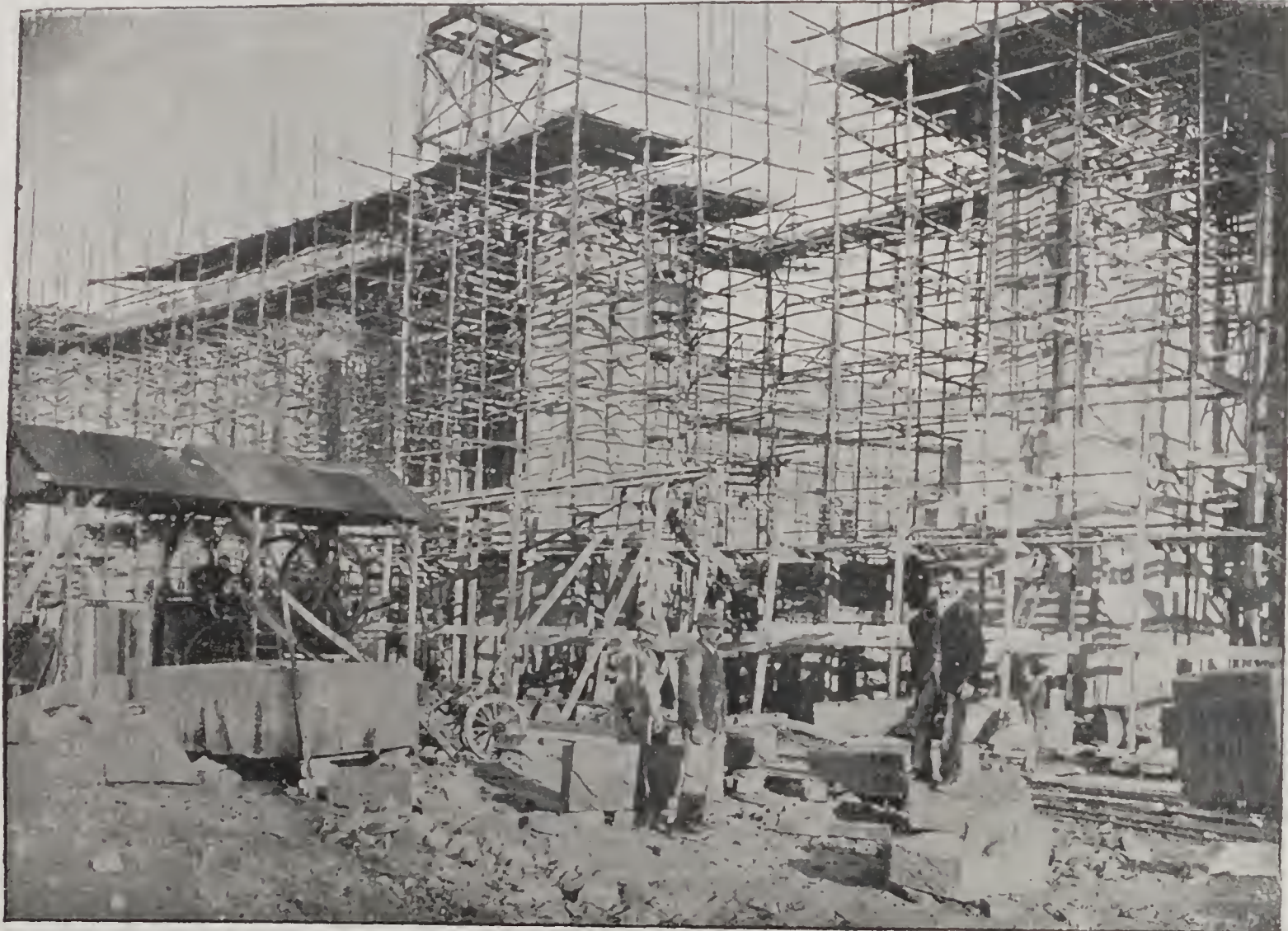
AUX CHAMPS-ÉLYSÉES. — Les échafaudages du Petit Palais.
